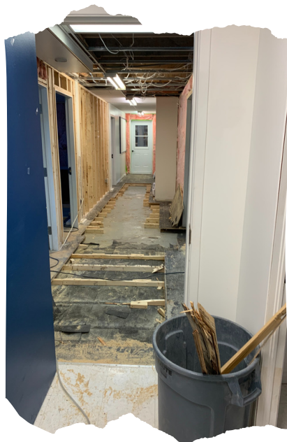
Sous-sol du Pavois lors des rénovations
